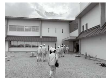
完成間近の新竜王小学校視察の様子
