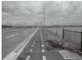
安全は点（灯）から線へ、線から面へ（上） 防犯灯設置が待たれる歩道（下）
